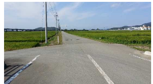
(上) 工事中のシーボルトライン
